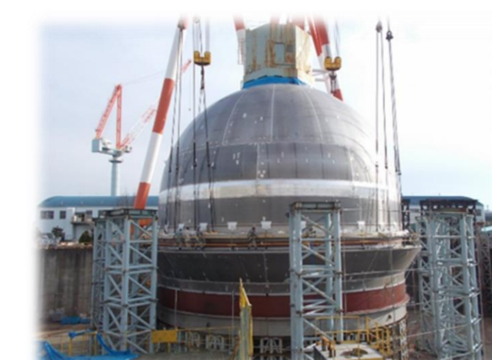
試験用タンクイメージ (NEDO助成事業「海上輸送大型化液化水素CCSの開発」の成果)
