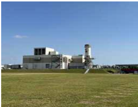
吉の浦マルチガスタービン発電所外観
