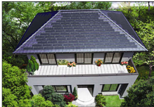
屋根の形状に合わせて、無駄なく太陽電池を敷き詰めることができる。（写真提供：株式会社カネカ）
