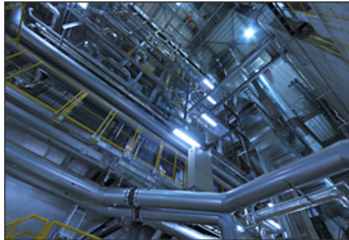
ストーカ炉を見上げたところ。 無数のパイプが張りめぐらされ、燃焼効率向上や 環境負荷低減の最新技術が組み込まれている。
