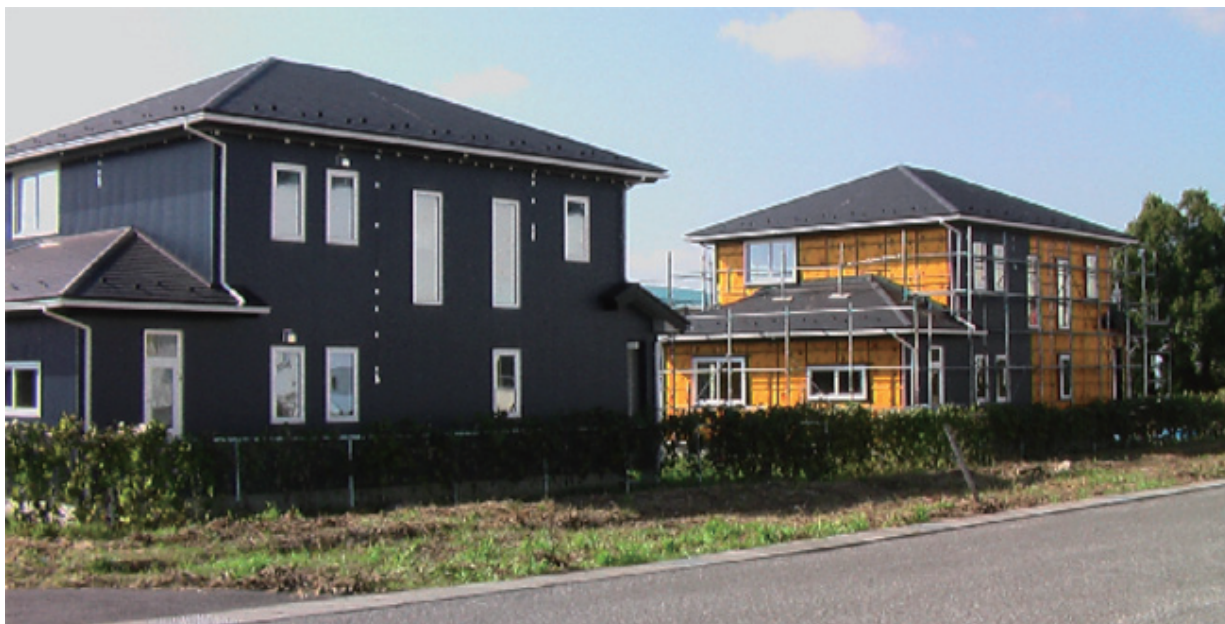
アキレス滋賀第2工場内に建設された実験住宅
