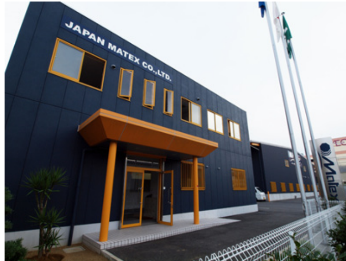
関西国際空港対岸のりんくうタウン内に新設された工場
