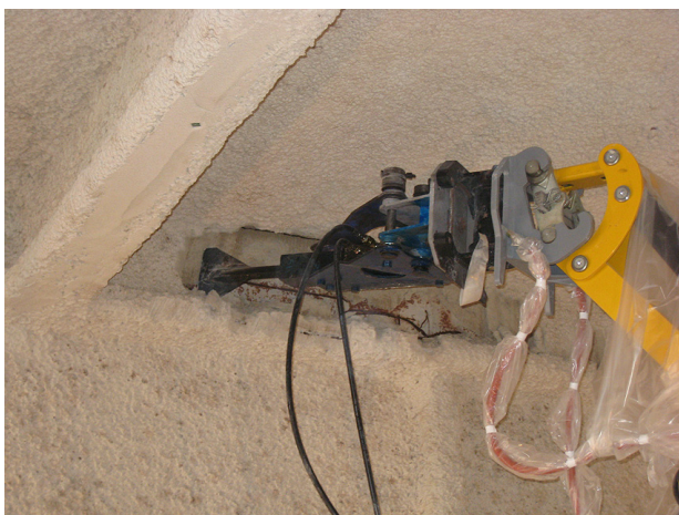
最初に開発した「打撃チョッパー方式」のアタッチメント
