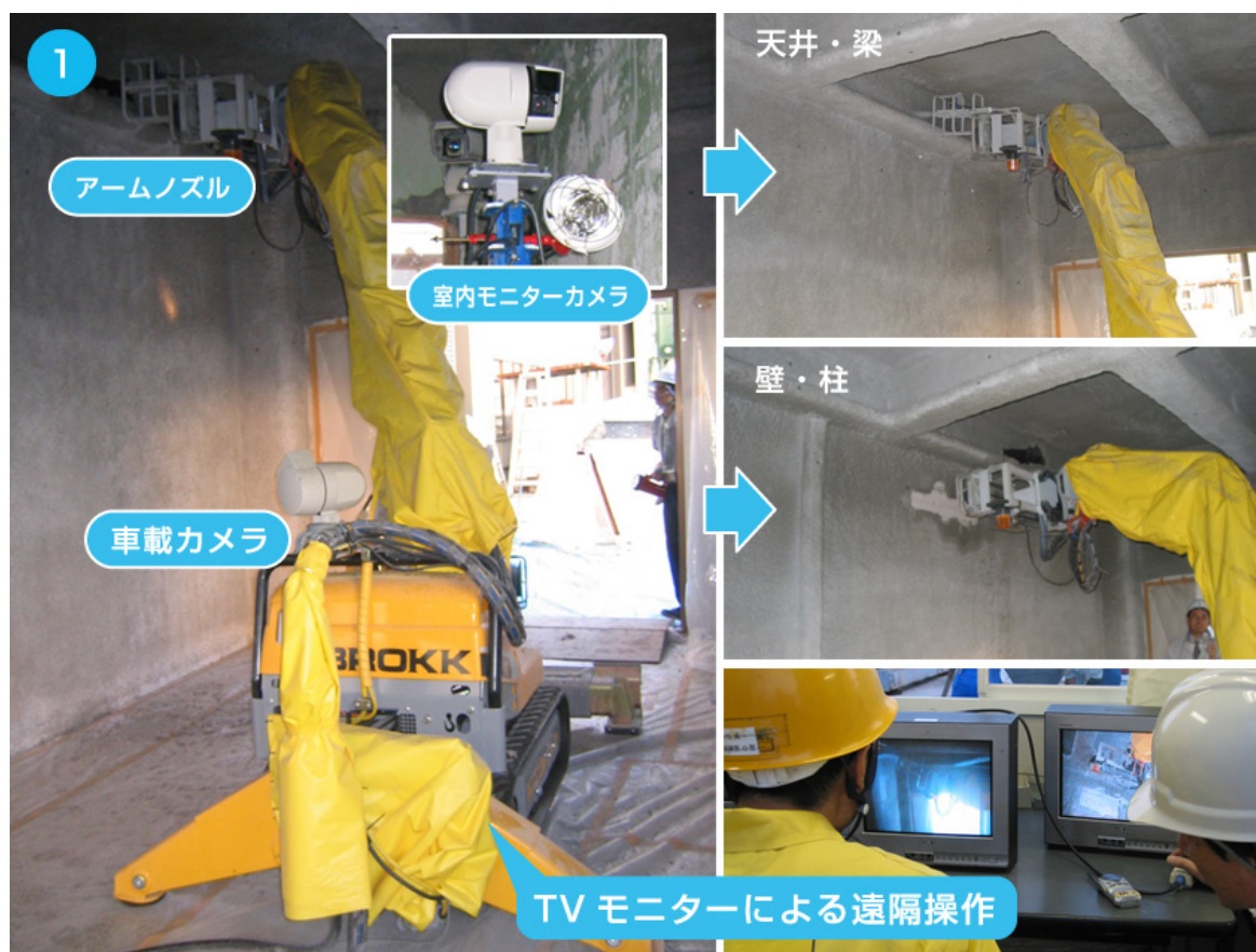
実証実験の様子（模擬アスベストの剥離と除去）
