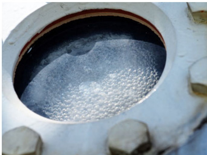
冷却缶の覗き窓に見える気泡（左）、燃焼炉の下部にある冷却缶（右）
