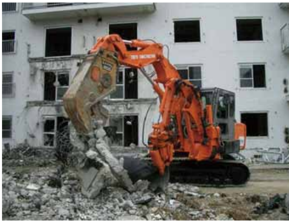
実際の解体現場で作業する試作機
