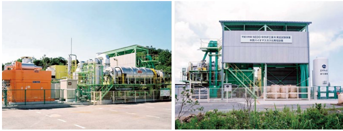
山口市に建設された実証プラント (写真提供：中外炉工業株式会社)
