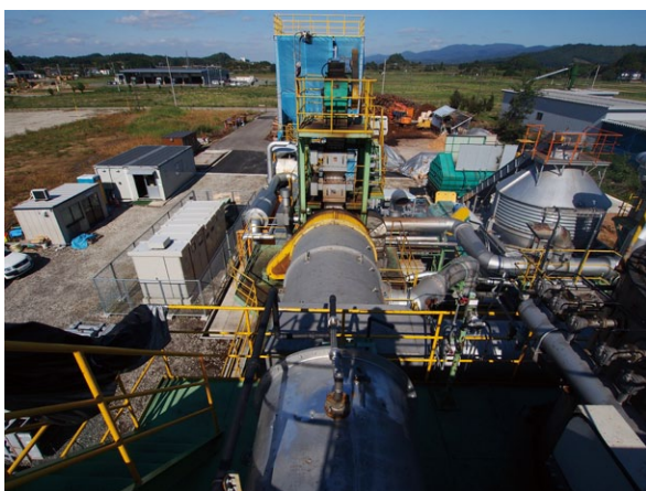
横手市で実証試験中のバイオマスガス化発電システム。 写真中央奥の青いシートに囲まれた場所がバイオコークスの製造設備
