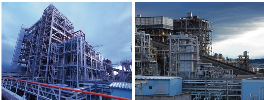
IGCC 連続運転の世界記録を更新した、常磐共同火力株式会社勿来発電所 10 号機
