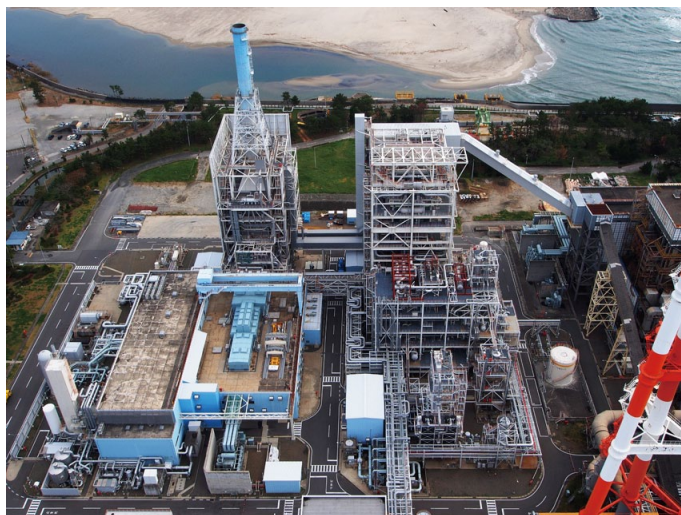
福島県いわき市にある IGCC25 万 kW 勿来発電所 10 号機（旧実証プラント）。 現在は、東京電力に系統連携し、震災復興への貴重な電源となっている。
