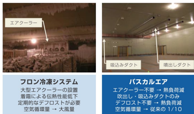
図7 従来の低温冷蔵倉庫(左)と「パスカルエア」を採用した冷蔵庫(右:入庫前) 「パスカルエア」の冷蔵庫はエアクーラーがなく広々とした空間となる
