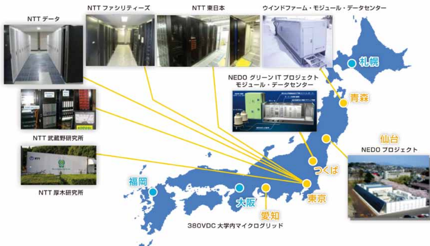
図 12 NTT ファシリティーズの直流給電システム実証導入した各地の給電システム（一例）
