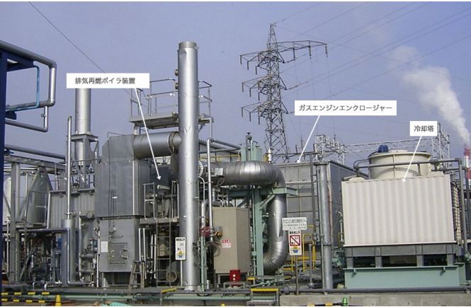
三井造船が開発した、ガスエンジンを利用した コージェネレーションシステムのフィールド試験設備 (写真提供:三井造船株式会社)
