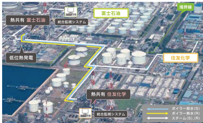
図6 富士石油と住友化学との共同事業。配管は片道約1.5km
