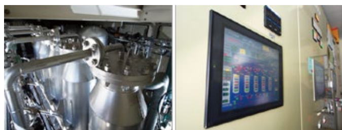
左・不純物の吸着と脱着を繰り返し、水素の純度を上げる 圧力スイング吸着装置(PSA)、 右・5塔のPSAを切り替え、その状況を示す制御盤
