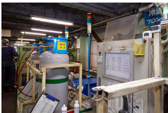
回収されたフロンは、常に重さを量ることで漏れていないかチェックするなど、厳密に管理されている
