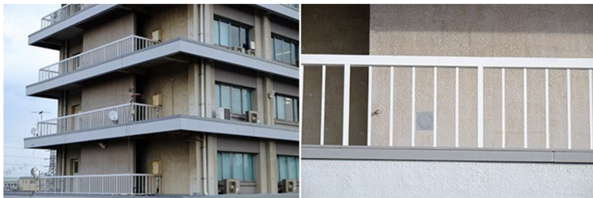
写真6 福岡県北九州市に 50 年前に実験的に建設された高炉セメントによるビル（左）、柵の向こうの灰色の四角い部分から耐久性を検査するコアを抜いた
