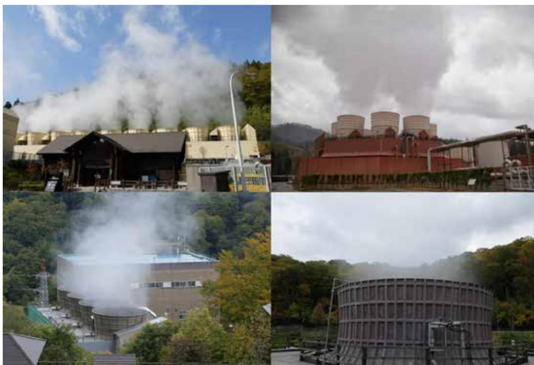
写真 1 地熱発電所の冷却塔から出る水蒸気および白煙（微量な硫化水素を含む）。排出源の高さが低いことが地熱発電所の特徴。左上：上の岱地熱発電所（秋田県）、右上：柳津西山地熱発電所（福島県）、左下：葛根田地熱発電所（岩手県）、右下：葛根田地熱発電所の冷却塔上部（出典：平成 25 年度～平成 27 年度成果報告書 地熱発電技術研究開発／発電所の環境保全対策技術開発／地熱発電所に係る環境アセスメントのための硫化水素拡散予測数値モデルの開発）
