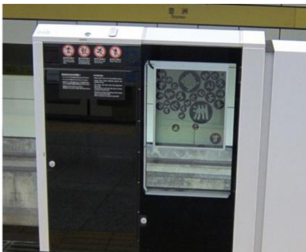
写真 4 豊洲駅の転落防止柵に設置された透明ディスプレイ。カラー表示でちゃんと映像として認識できる（左）。モノクロ表示だと、背景が透けて見えるのがよくわかる（右）（資料提供：シャープディスプレイテクノロジー株式会社）
