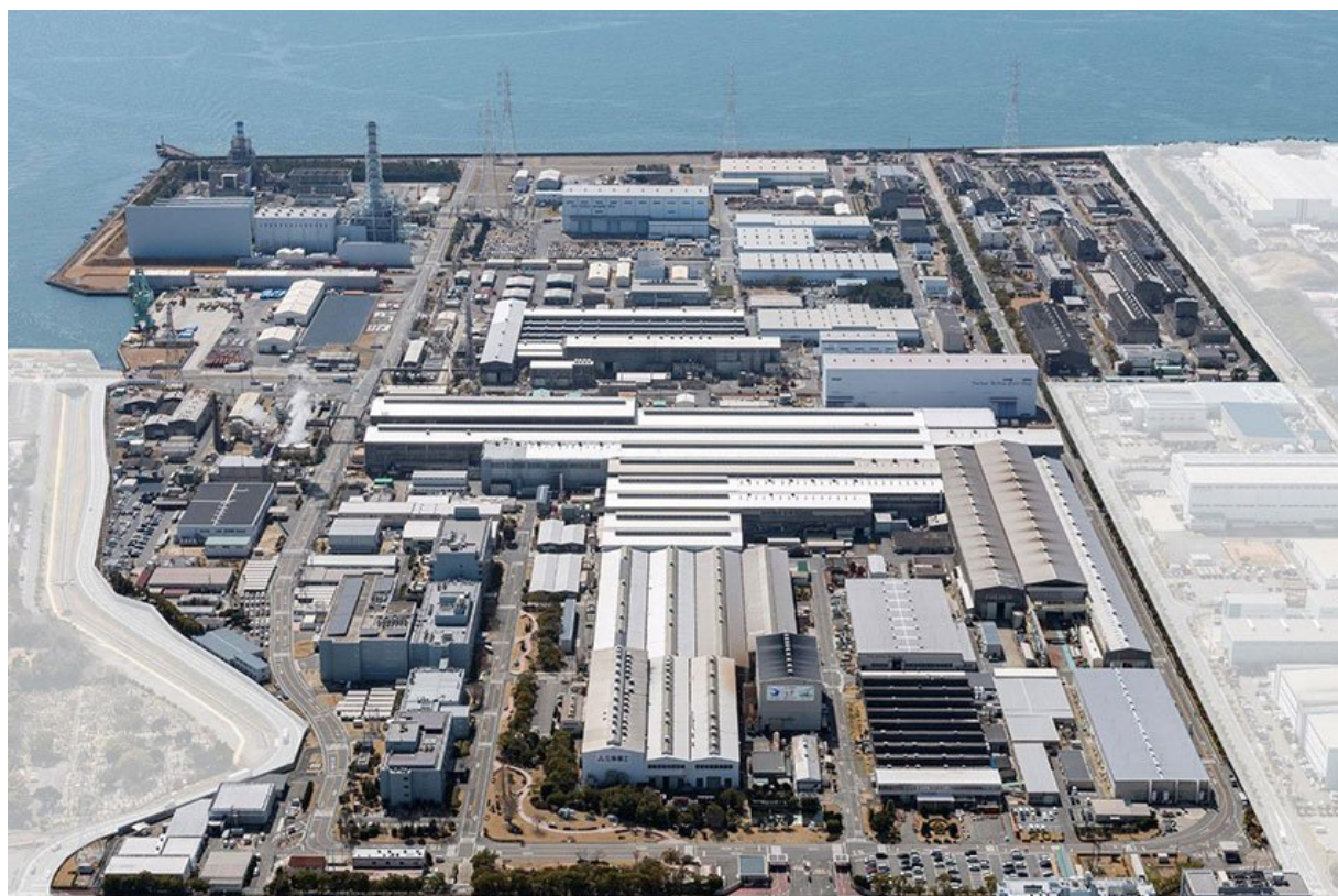
写真1 広大な敷地を有する三菱重工の高砂製作所（資料提供：三菱重工業株式会社）
