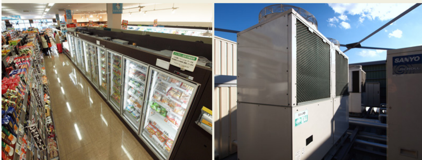
(左) 店舗内の冷凍ショーケース、(右) 店舗の屋上に設置されたノンフロン冷凍機
