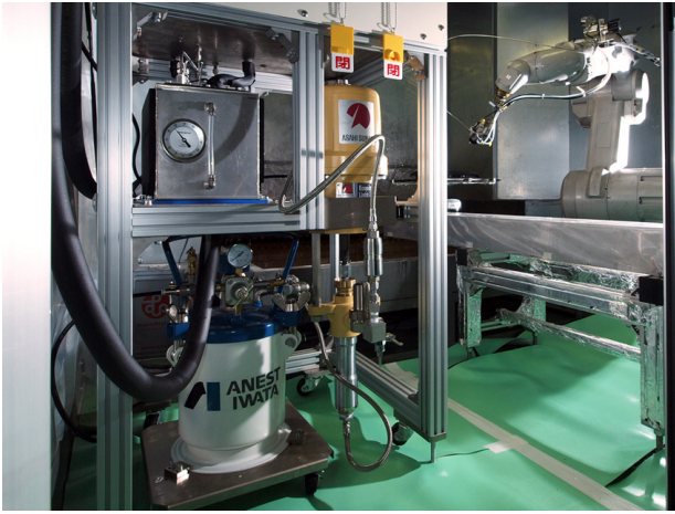
吹き付けユニットの塗料タンク
