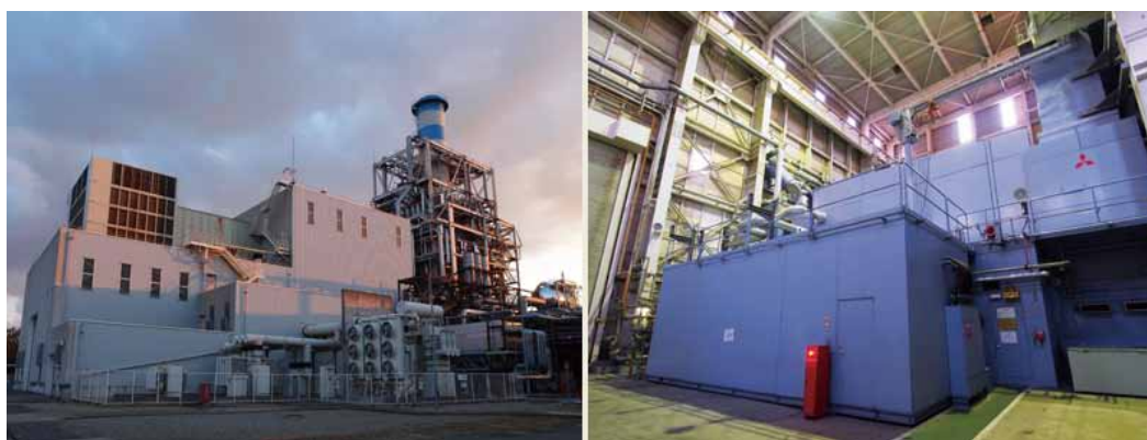
三菱重工高砂製作所内にある実証プラント外観（左）、プラント内のガスタービン（右）
