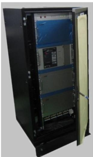
図 4-1-11 保護検出装置（三菱電機製、3 回線分× 1 台）
