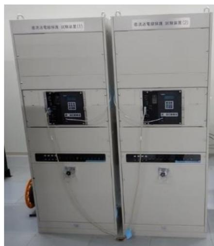
図 4-1-12 保護検出装置（日立製作所製、1 回線分× 2 台）
