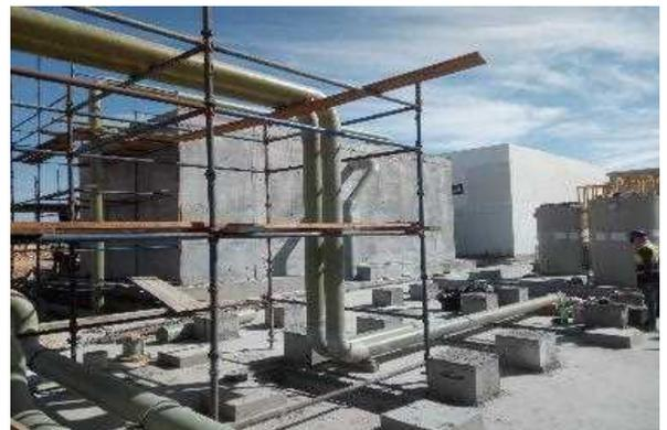
図21. BWRO機器用配管工事 (SWCC)
