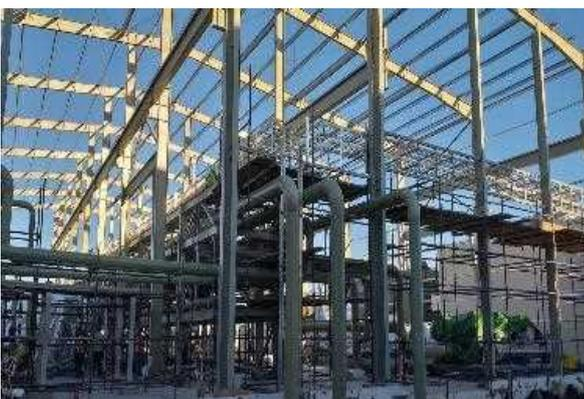
図22. SWRO機器用配管工事 (SWCC)
