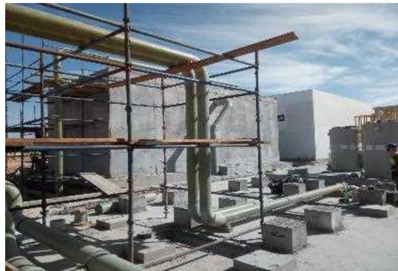
図21. BWRO機器用配管工事 (SWCC)
