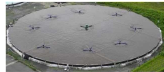
【増殖 + オイル蓄積】オープン型培養装置
