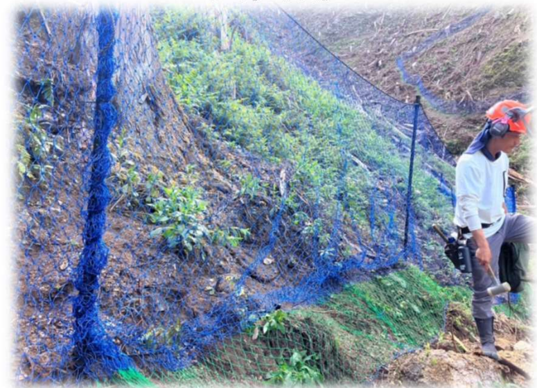
防獣ネット設置完了 15 / 20
