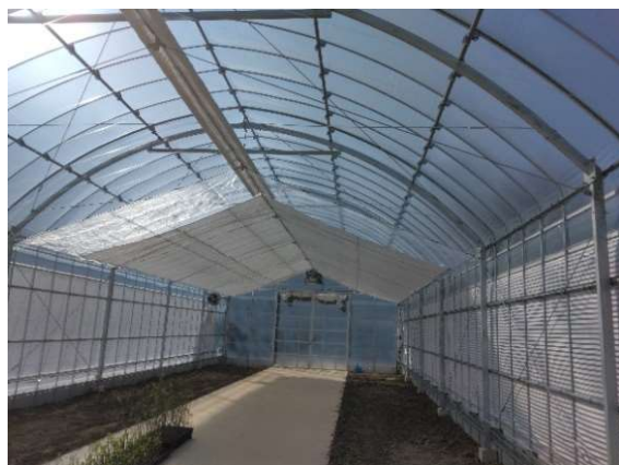
新設ビニールハウス
