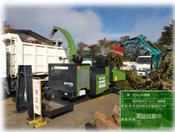
現地破砕状況
