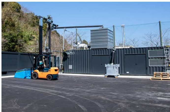
うすきエネルギー所有のSpannerガス化発電装置
