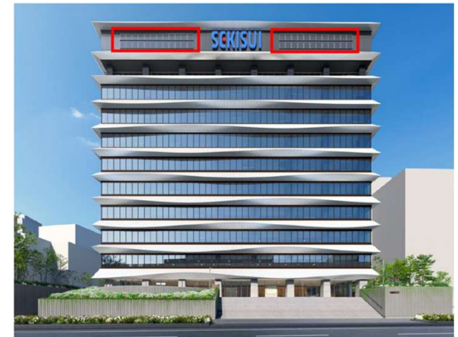
大阪本社 リニューアル完エイメージ（赤枠内がフィルム型ペロブスカイト太陽電池）
