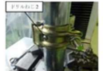
架台補強例
