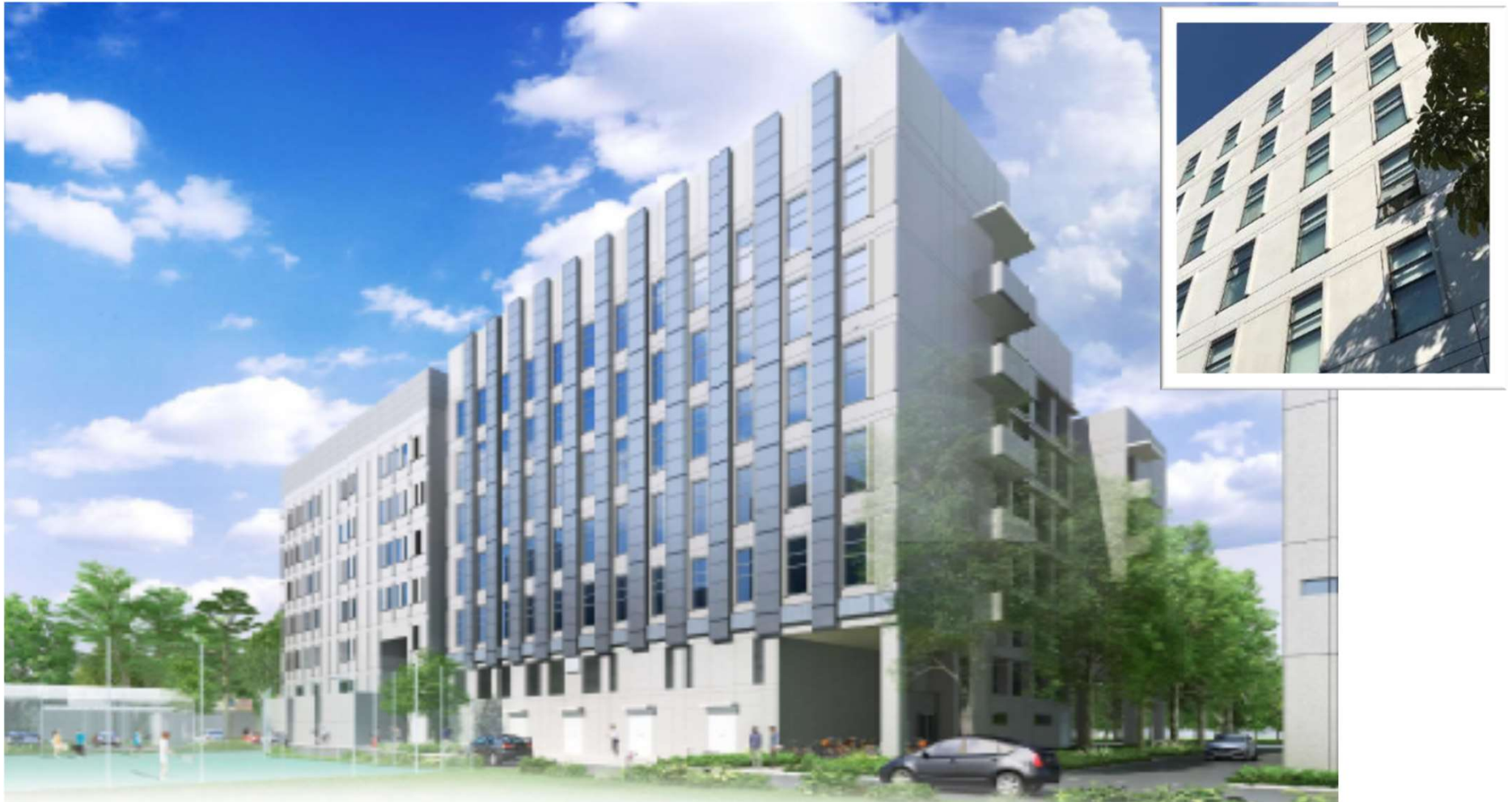
壁面PV設置後イメージパース図 (東京大学先端科学技術研究センター3号館南棟西壁)
