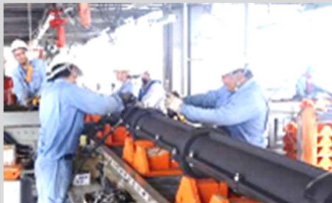
1.①従来の敷設船上でのケーブル防護管取付例 (本事業で自動化・高速化の開発を予定)
