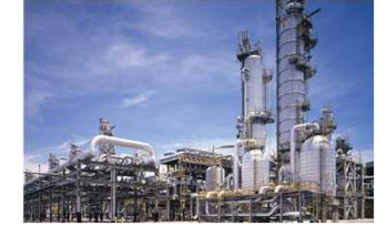
LNG液化プラント
