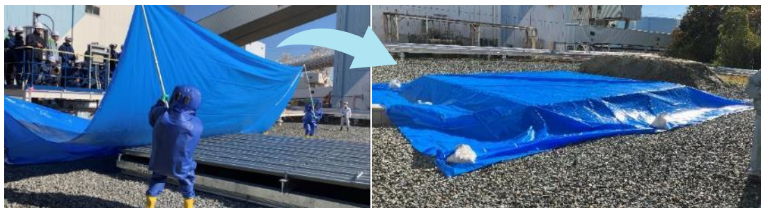
③ タープ&カバーによる溜め升内の低温液アンモニアの蒸発拡散抑制
