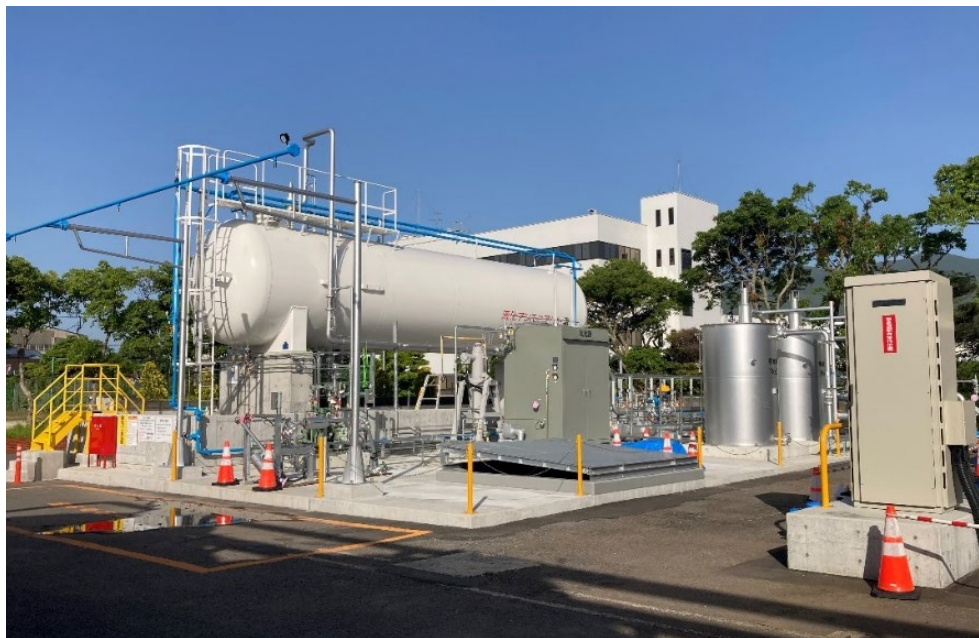
燃料アンモニア貯蔵・供給設備
