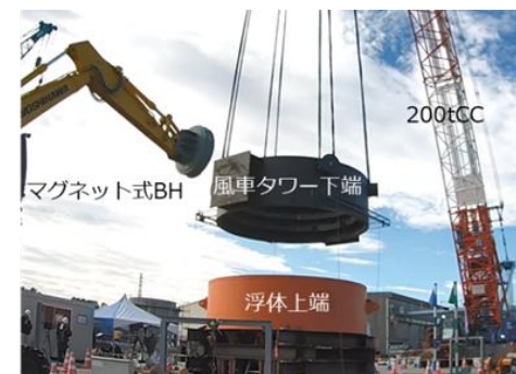
施工実証の状況 (1/3スケール)
