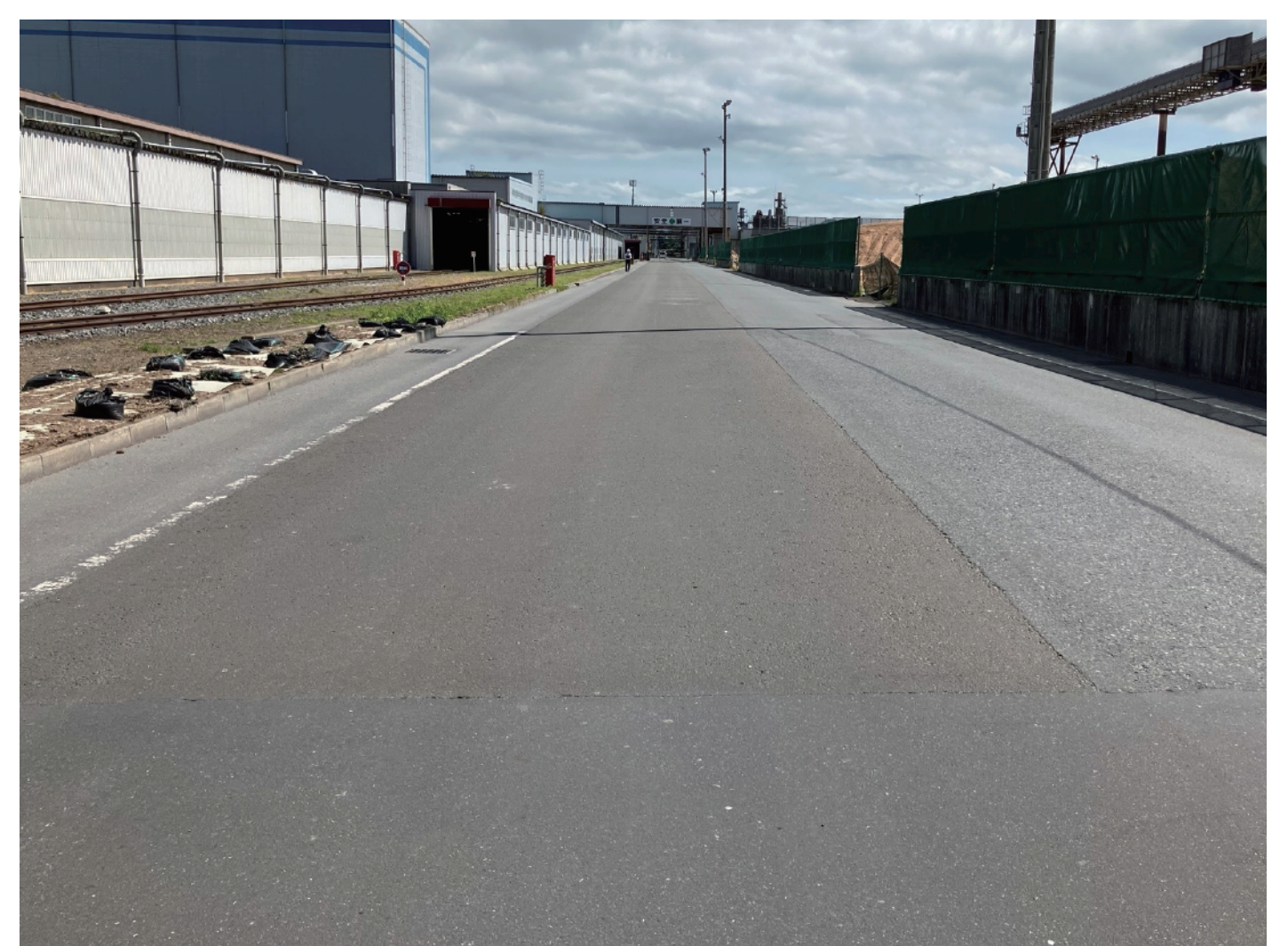
工場内通路の供用状況 (リグニン置換率13wt%)
