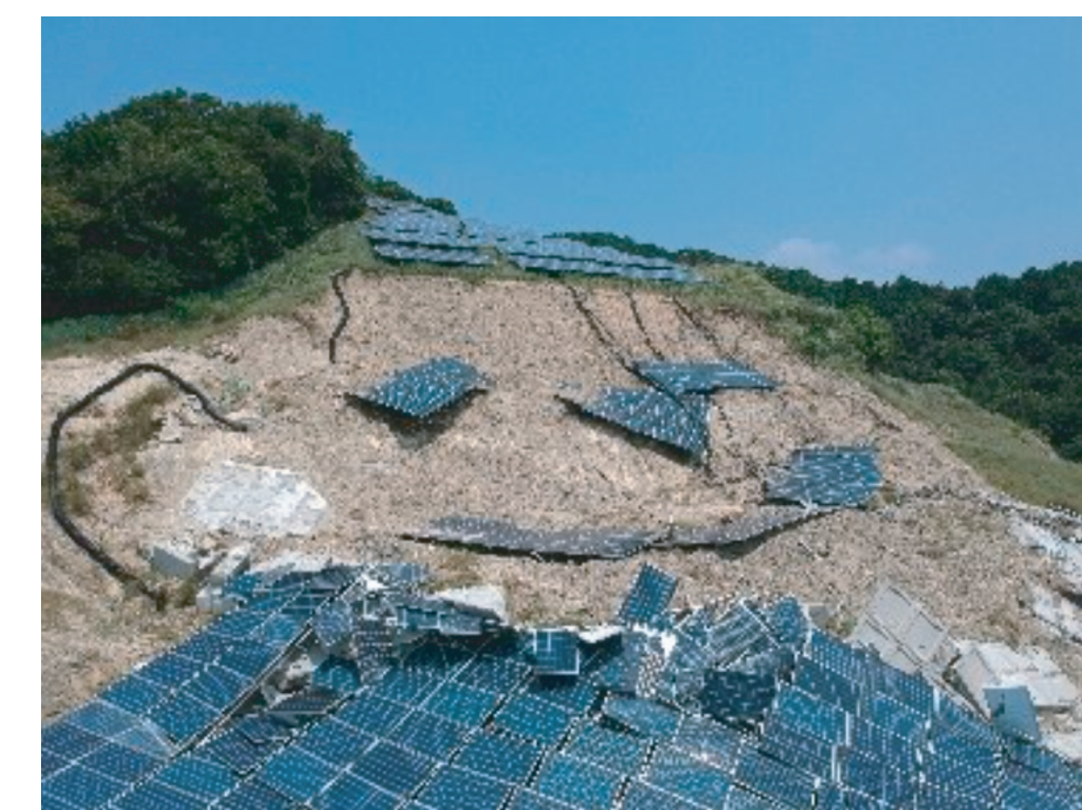
急傾斜地における被害
