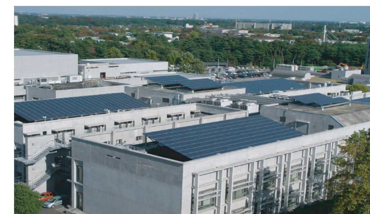
建物設置型PV
