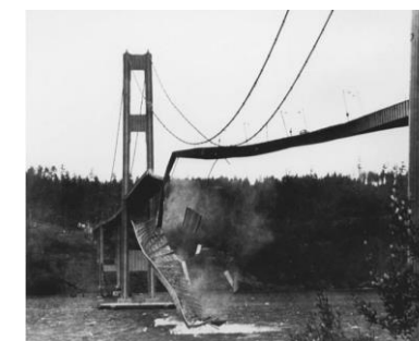
強風による共振により崩壊したタコマ橋（1940年）
