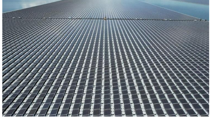
図5-2-3-6 タイ・シリンドホーン・ダム(北東部) 大規模水上発電設備 出典：Stockholm Environment Institute 発電出力：45MW(2021年商業運転開始) 太陽光発電と水力発電の併用のため、送電線と変圧器を共用。
