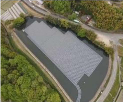
図5-2-3-5 香川県さぬき市長谷池水上太陽光発電所 出典：四国電力HP 発電出力：750kW(2022年7月8日営業運転開始 農業用のため池に設置
