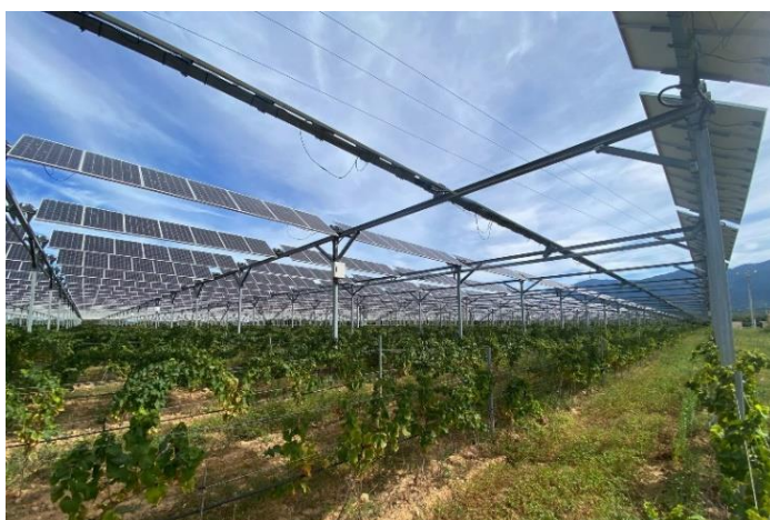
図5-2-3-12 可動式太陽光発電システム
