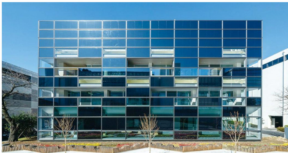
図 5-2-4-3 意匠性を向上させた太陽電池モジュールの建物壁面への設置例
