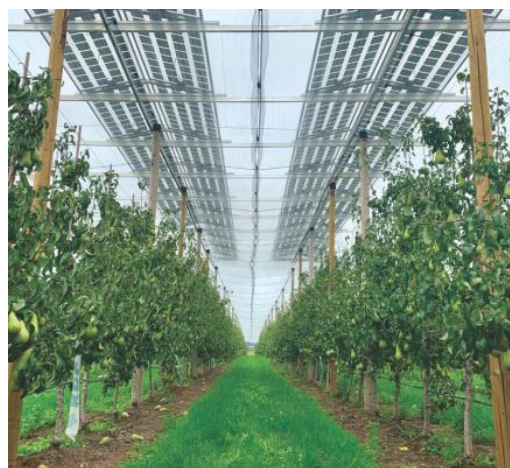
図5-2-3-13 可動散乱ライトスルー（光透過型）太陽電池モジュール
