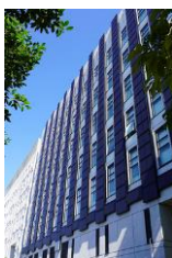
東大・先端科学技術研究センターに設置した壁面太陽光発電（株）カネカ
