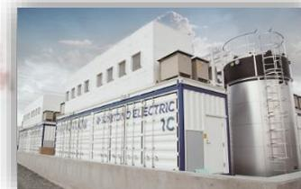
蓄電池の送電・配電併用運転実証（米国）
