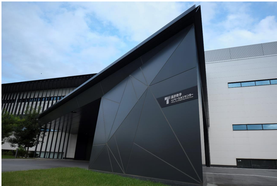
写真 1 高砂熱学イノベーションセンター
