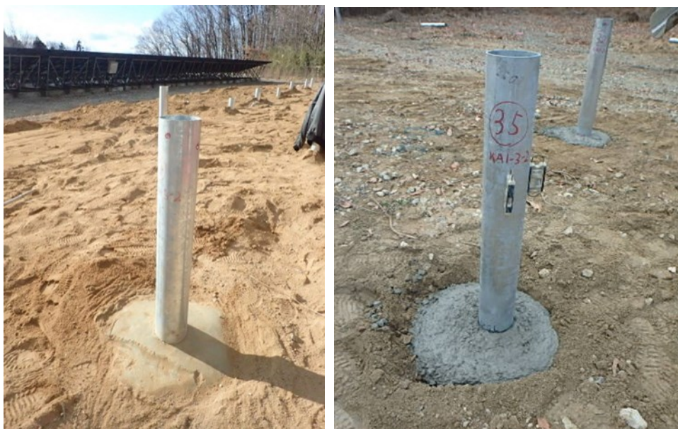
柱状改良杭に鋼管杭埋設
