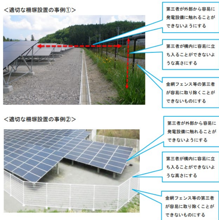
図 13-14 適切な高さ、柵の設置事例 13-46)
