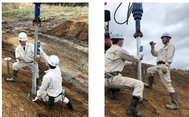
(a) スクリュー杭の施工例（回転貫入）
