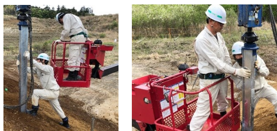
(b) 形鋼杭の施工例（打撃貫入）
