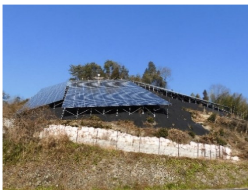
写真 7-1 大型アレイの設置事例（撮影：構造耐力評価機構）
