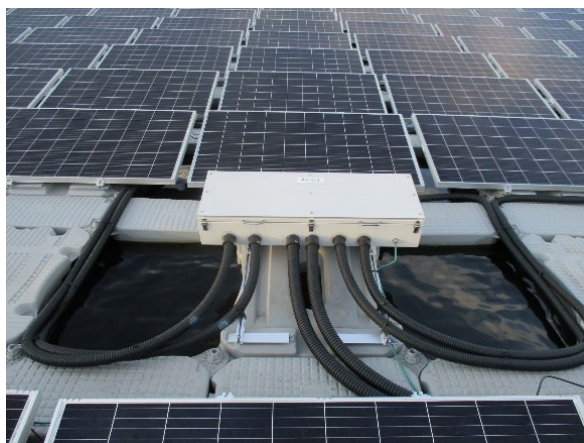
写真 12-3 接続箱の設置例
