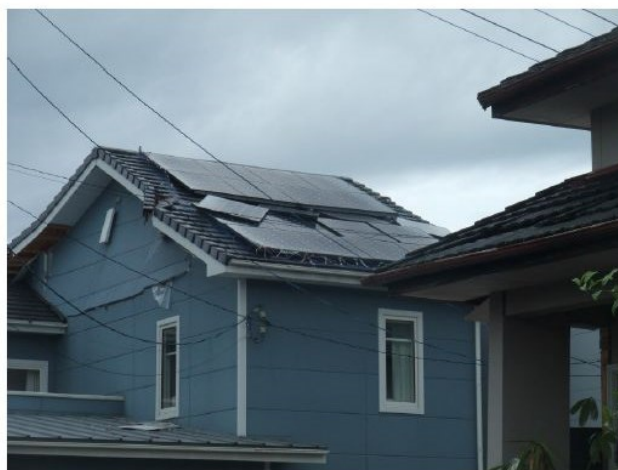
写真 2-4 住宅に設置された太陽光発電設備の地震被害事例 (出典：太陽光発電所ネットワーク提供)
