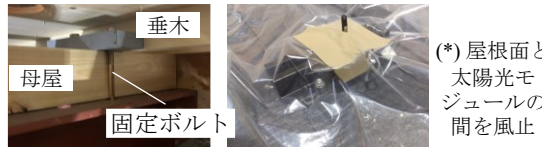
試験体の固定 風止(スレート屋根)
